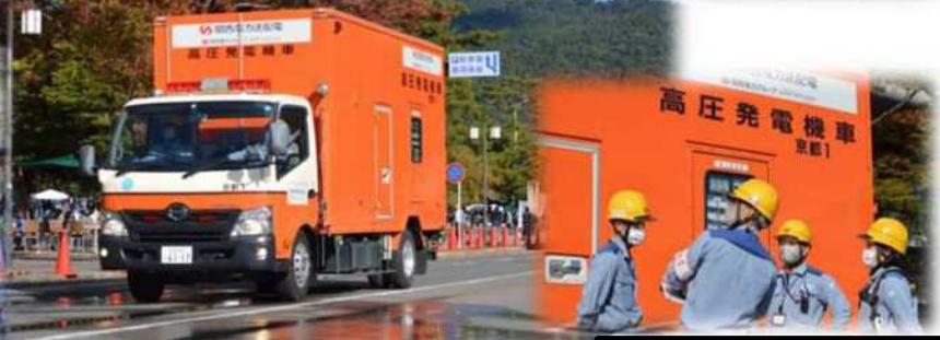
応急送電訓練
